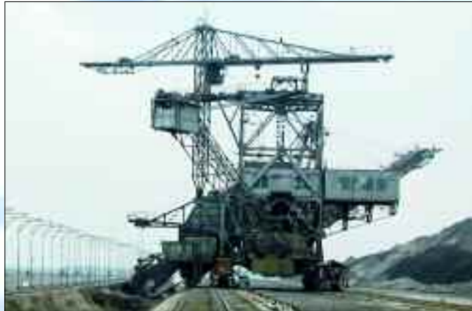
Sanierungsarbeiten mit schwerer Technik für die LMBV
