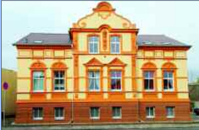
Komplettsanierung, eine neue Fassade oder ein neues Dach ...
