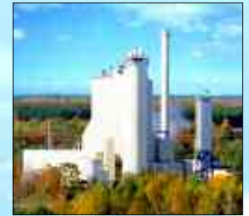
Das Kraftwerk der GMB liefert seit 1999 Strom und Wärme für Senftenberg
